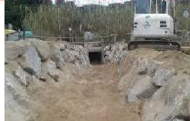
2. Restauració ambiental i paisatgística del Rial de la Serp des de l'autopista fins a la platja del Cavaió:
